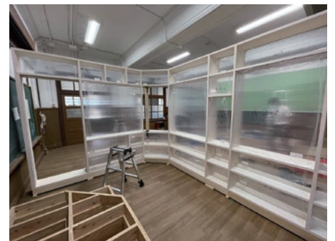
施工過程 ポリカーボネート板の溝を突いたパネルを連結し組み立てます
